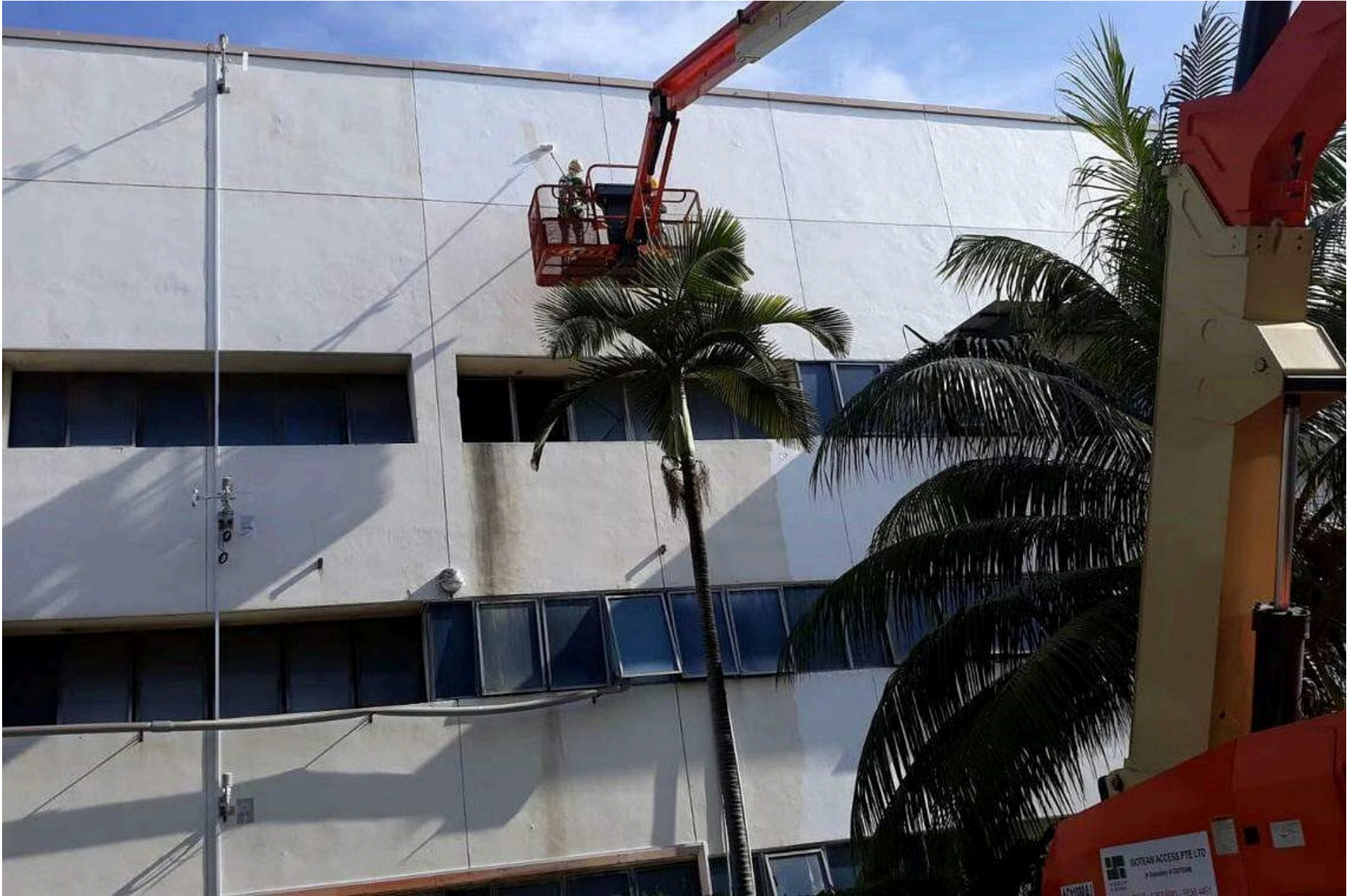
整体而言，漆上隔热涂料的建筑所散发的热量可降达30%，建筑周围气温可随之降达2摄氏度，人走在街道上感受到的环境温度也会减低约1.5摄氏度。（南洋理工大学提供）
