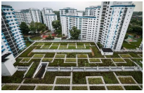
建屋局将用无人机空拍热成像 研究绿化屋顶和隔热漆降温成效
