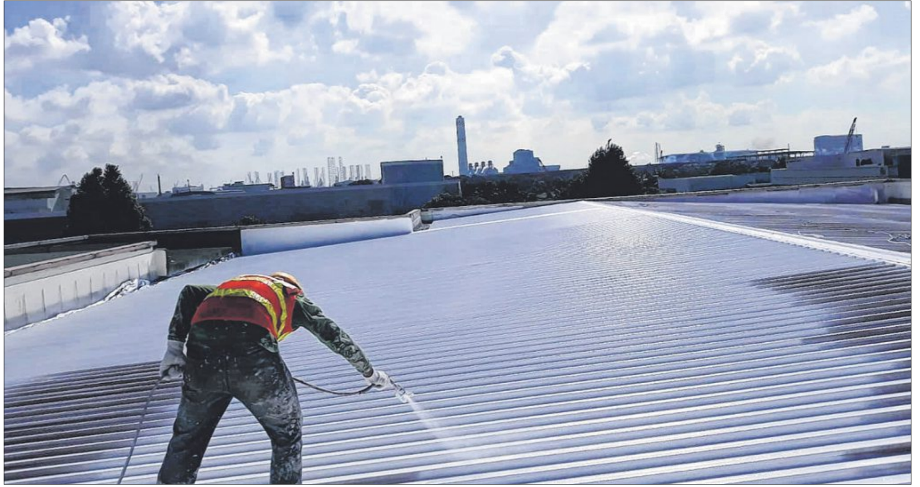
南洋理工大学研究团队在新加坡西部的工业区，为指定建筑漆上隔热涂料，并采集空气流动性、表面和空气温度、湿度和辐射等环境数据，以了解隔热涂料对于降低城市热量的效果。（南大提供）
