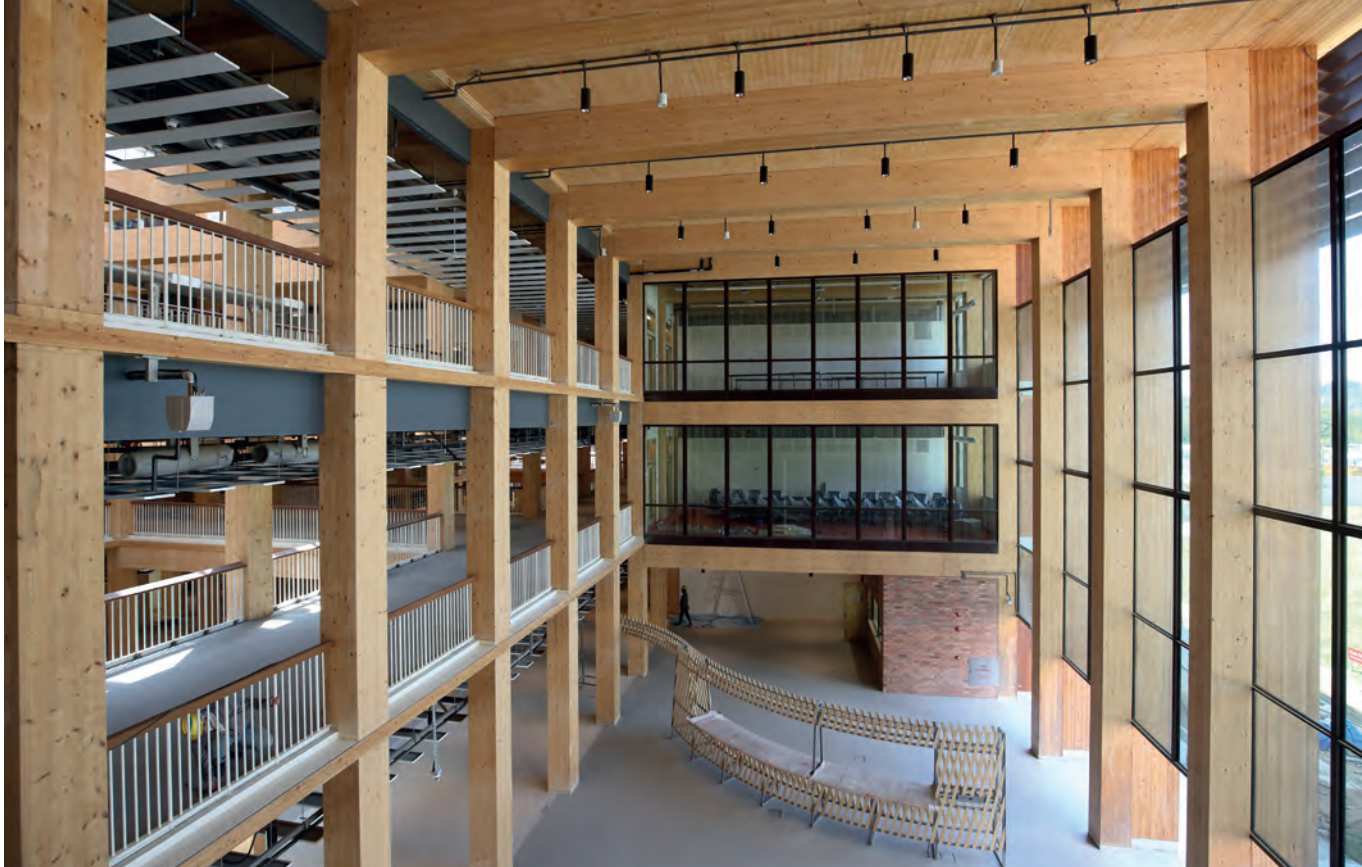
Het gebouw heeft een modulaire constructie met gelamineerde houten liggers en kolommen.
