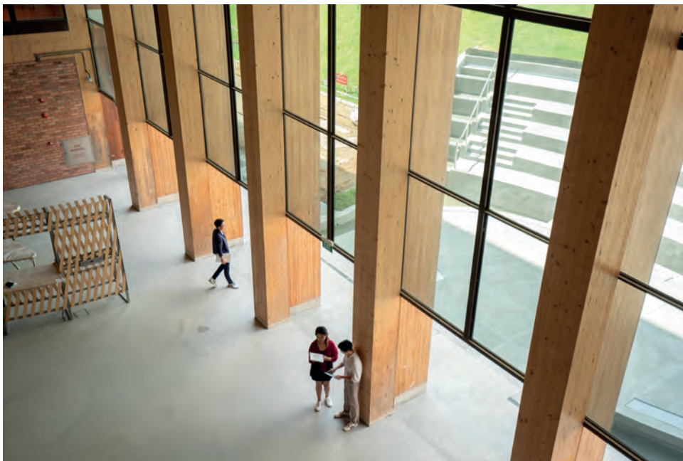
Het buitendeel van de gelamineerde gevelkolommen is uitgevoerd in lariks.
