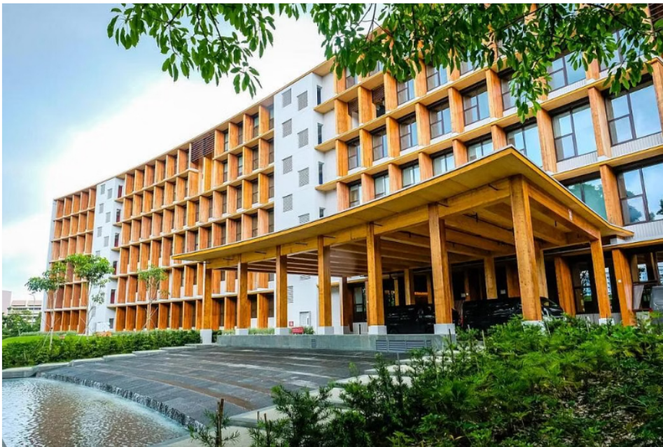
BANGUNAN BARU: Bangunan Gaia dibina menggunakan teknologi pembinaan inovatif dan hijau yang dikenali sebagai kayu besar tereka bentuk. - Foto NTU
