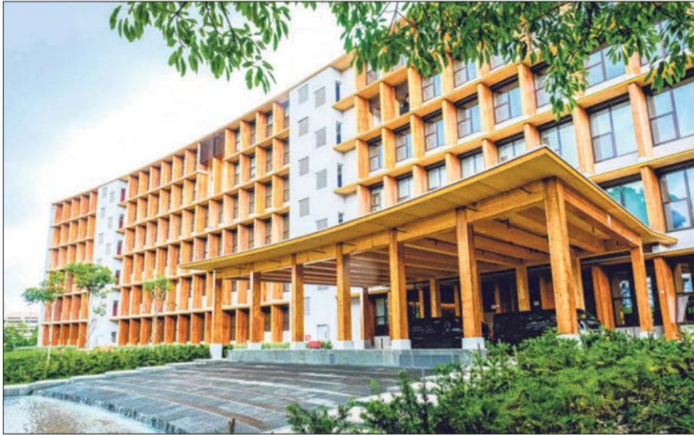
BANGUNAN BARU: Bangunan Gaia dibina menggunakan teknologi pembinaan inovatif dan hijau yang dikenali sebagai kayu besar tereka bentuk. – Foto NTU
